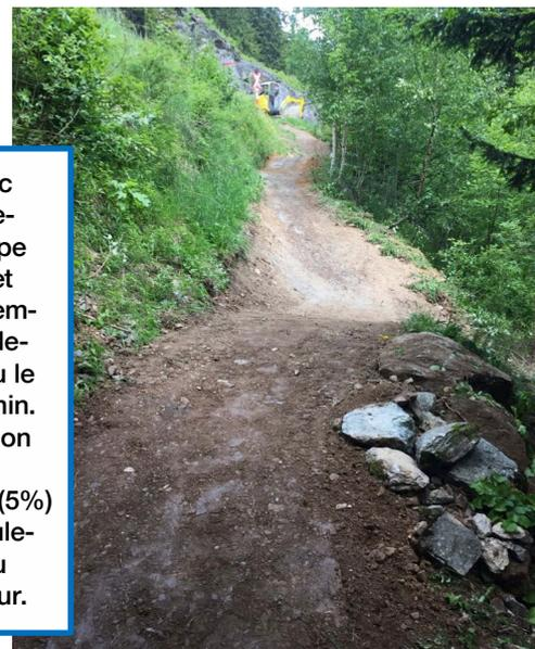
Exemple de dépression ponctuelle avec contrepente sur 3-5 m de longueur. L'eau peut s'écouler
