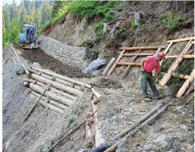
Exemple de caisson en bois à l'aval et de treillage à l'amont du chemin
